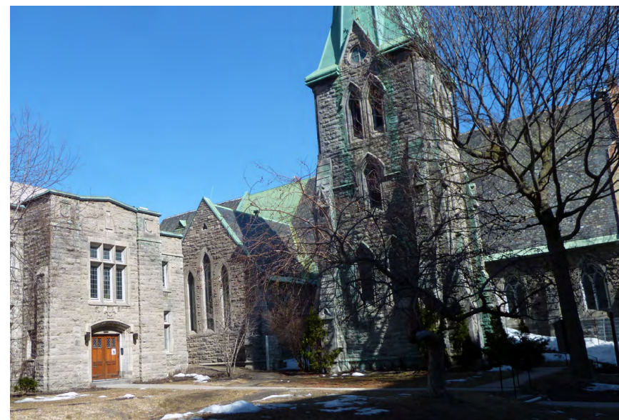
Église St-Jax Source : Rayside Labossière
